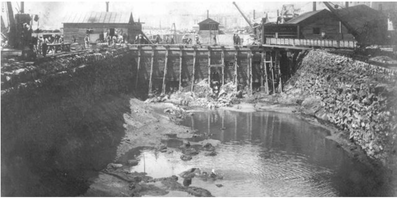
Construcción del Dique de Gamazo. Archivo Autoridad Portuaria de Santander.
