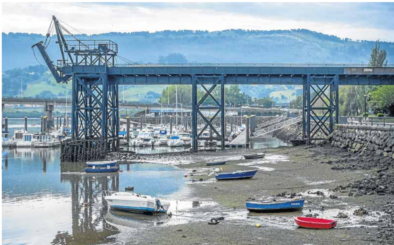
Puente de los ingleses en El Astillero, uno de los yacimientos industriales a conservar. DANIEL PEDRIZA
