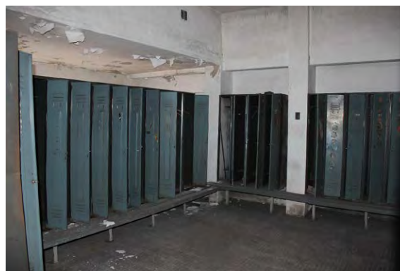
Figura 4. Casa de Aseos del pozo Sotón antes de la intervención.
