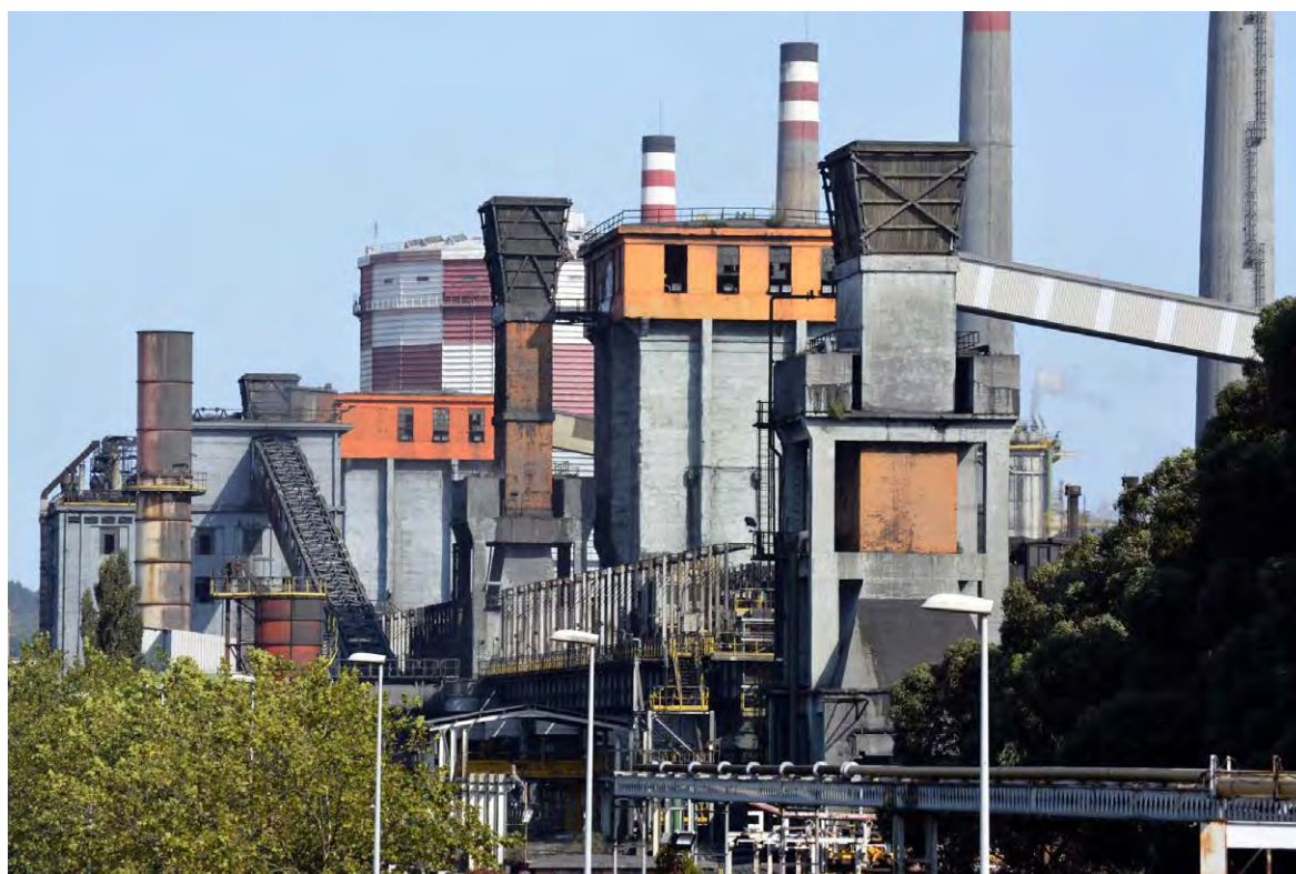
Planta de baterías de hornos de cok de ENSIDESA.
