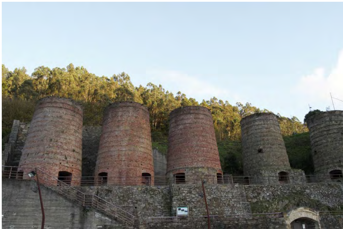
Figura 12. Batería de hornos de calcinación en Puentenuevo (foto cortesía de Manuel Antonio Huerta Nuño).
