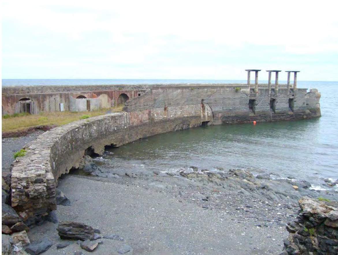
Figura 10. Dique de abrigo en la ensenada de Llumeres (Gozón).
