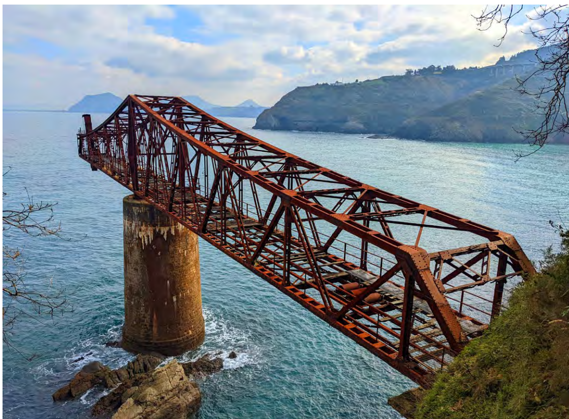
Figura 7. Cargadero de Dícido (Castro Urdiales).
