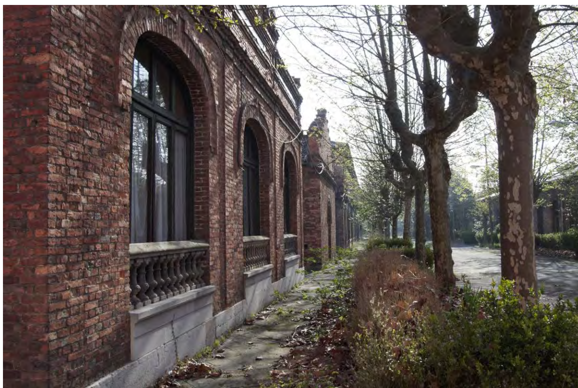
Fig. 4: Avenida principal de la Fábrica de Armas de La Vega (Foto del autor).
