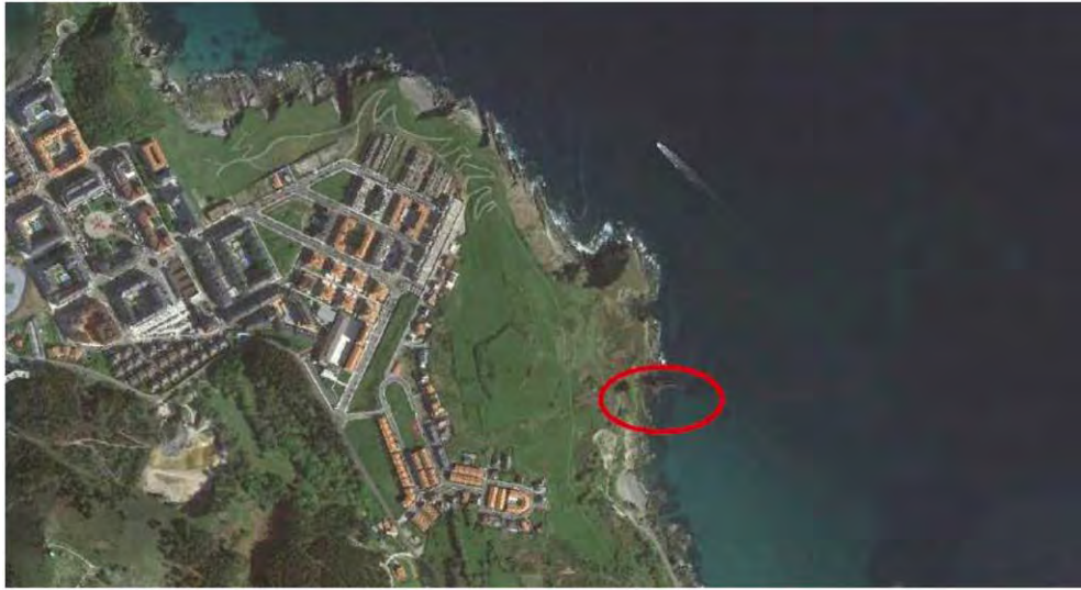
Figura 2. Localización del cargadero de Dicedo. Fuente: Google Earth
