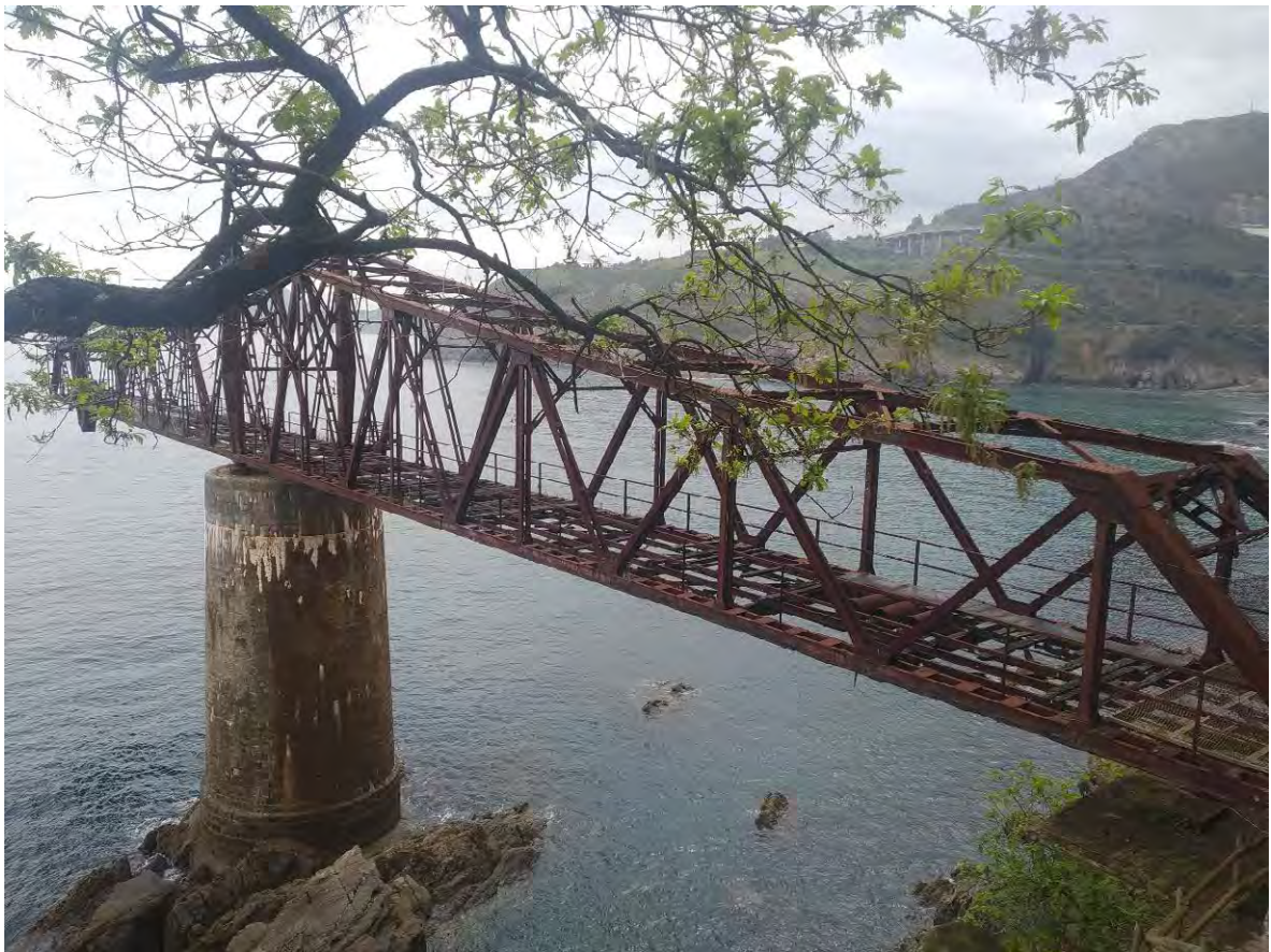
Figura 3. Vista del Cargadero de Dicedo
