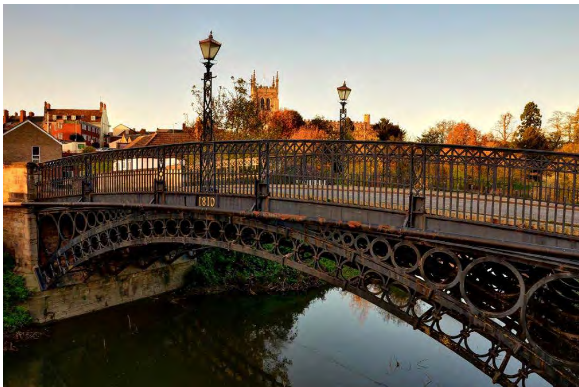
Figura 1. Tickford Bridge, St John St, Newport Pagnell (Reino Unido).
