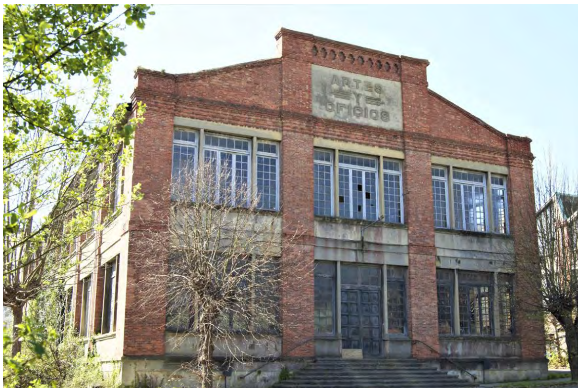
Fig. 3: Estado actual del edificio de la Escuela de Artes y Oficios (Foto del autor).
