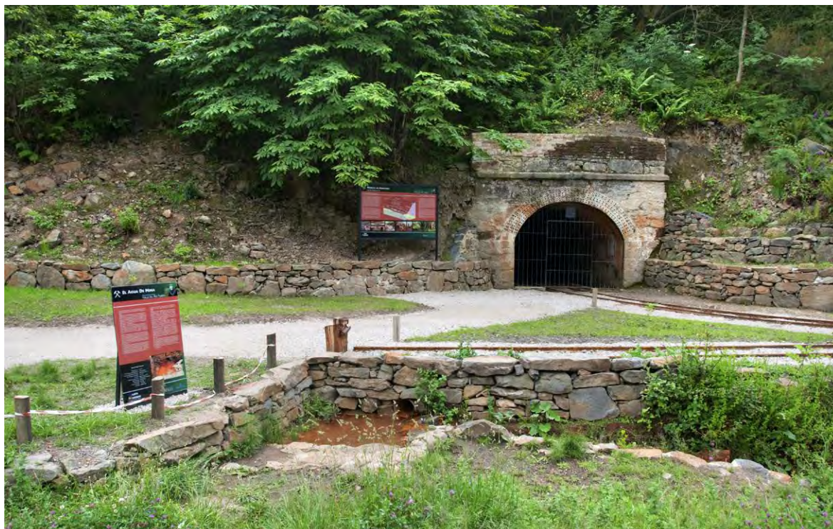
Figura 3. Socavón o piso 1º Rebaldana.
