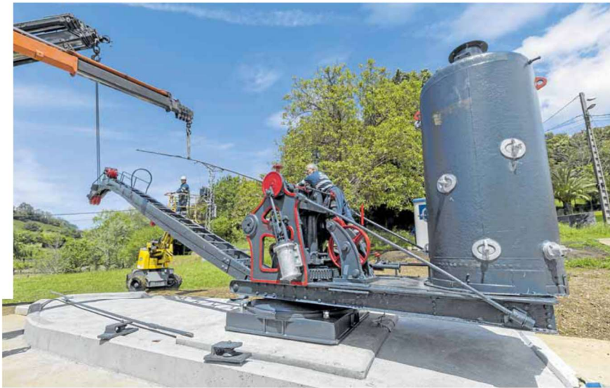
Operarios instalan la grúa en la recreación de una gabarra instalada junto al Ayuntamiento en La Concha de Villaescusa. FOTOGRAFÍAS: ROBERTO RUIZ
