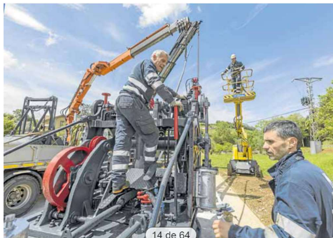
La máquina ha sido instalada cuidadosamente pieza a pieza.
